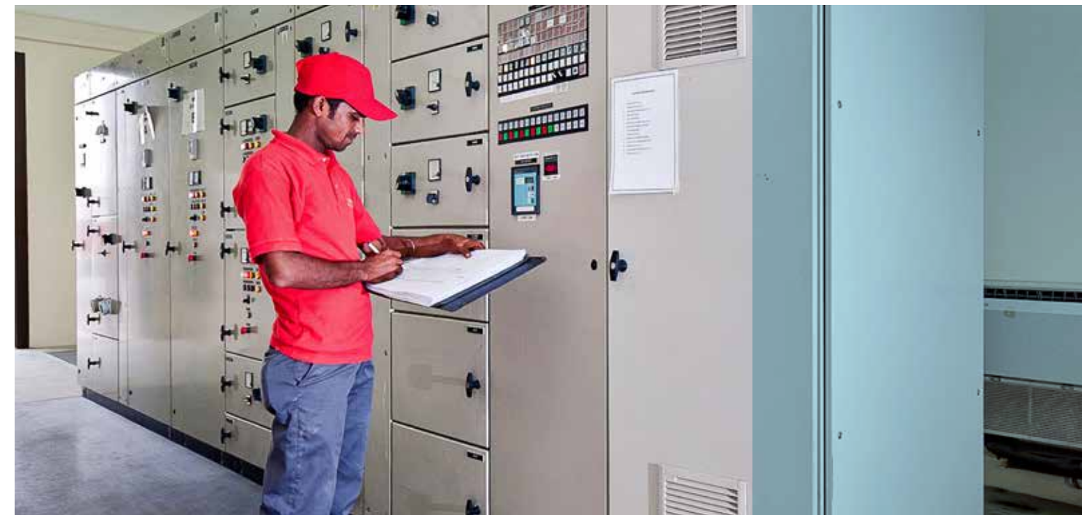
STATION D'EPURATION DES EAUX D'EGOUTS AJMAN Ajman, EAU
